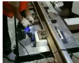
轨枕空隙植筋
