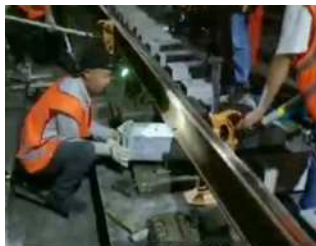
安装摆放短轨枕
