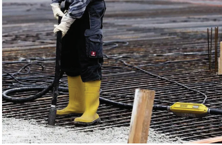
图2 混凝土振捣施工
