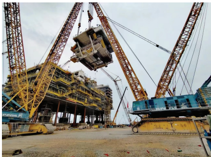
图1 多机抬吊作业
