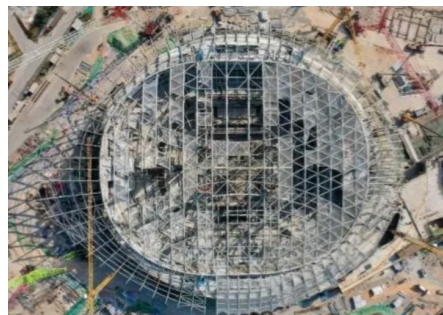
图1 体育馆钢屋盖现场吊装实景图
