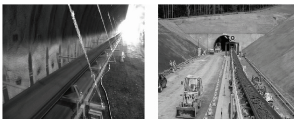
图1 盾构中的皮带机
