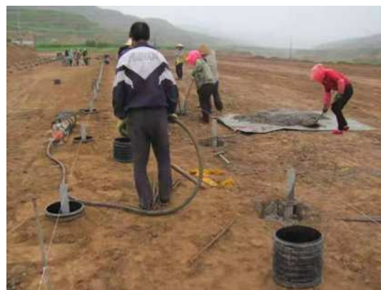
图 2 通渭县光伏电站项目取样点
