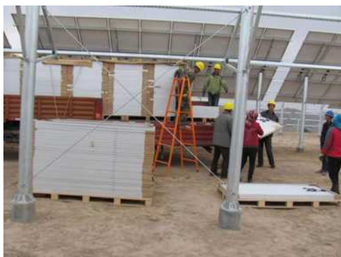
图 1 光伏电站支架及桩基础
