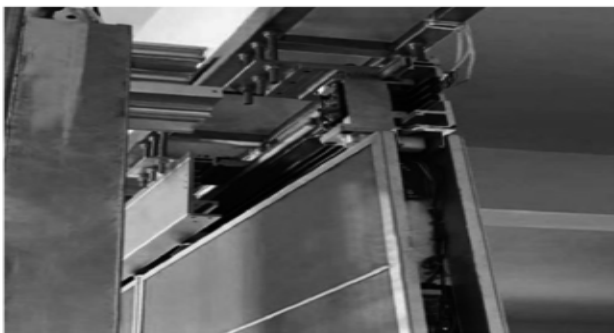
图 5 智能隔声活动隔墙单元安装
