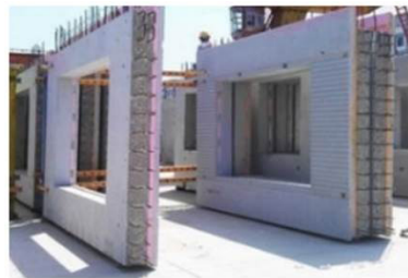
图1 模板安装现场
