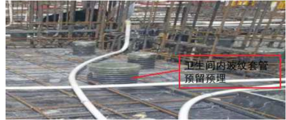
图6 卫生间排水套管预埋
