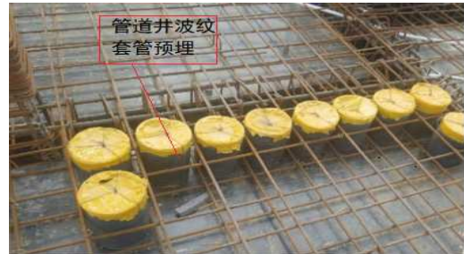
图7 管道井套管预埋
