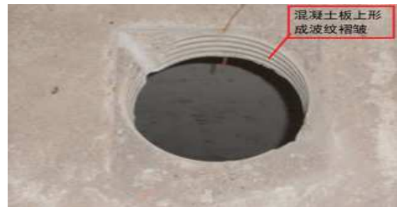
图7 管道井套管预埋
