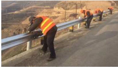
图4 防撞护栏维修
