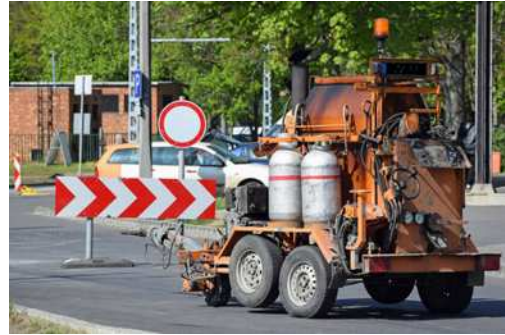
图3 交通标志安装
