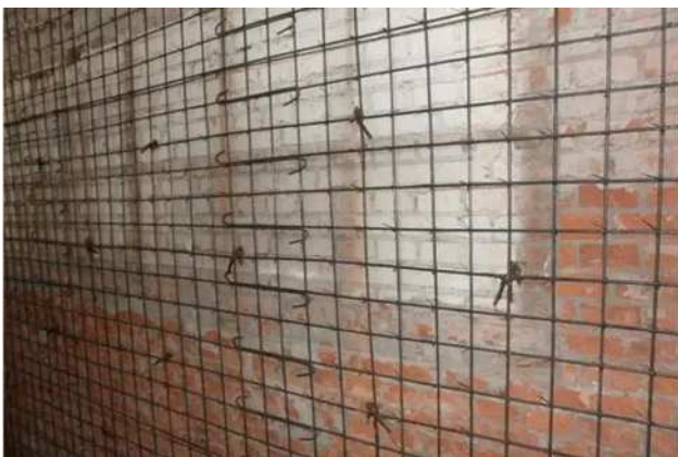
图2 钢筋网水泥砂浆加固的墙体
