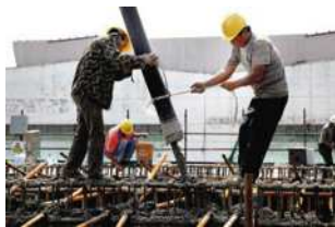
图3 混凝土浇筑
