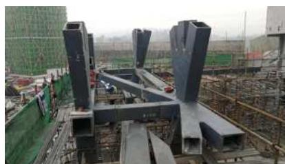
图2 装配式建筑铸钢连接节点
