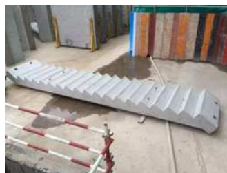
图2 装配式建筑楼梯结构
