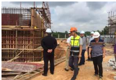
图2 检查东成镇污水处理工程
