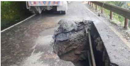
道桥沉降段路基路面在长期运行且受压状况下,极易产生塌陷问题。由于道桥沉降路段土质较为疏松,路面结构受力不均匀,出现剪切力过大的现象常有发生,将会对道路桥
