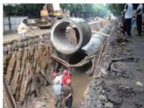
图1 市政道路中的给排水系统工程施工现场
