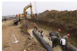
市政工程施工现场
