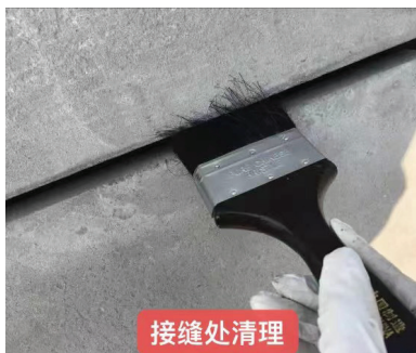
图4-1 接缝处周围清理
