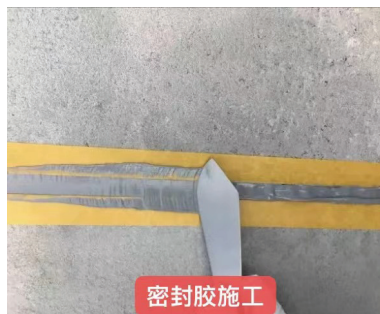
图3-1 接缝处密封胶施工
