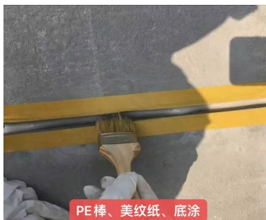
图4-2 施工前的底涂处理
