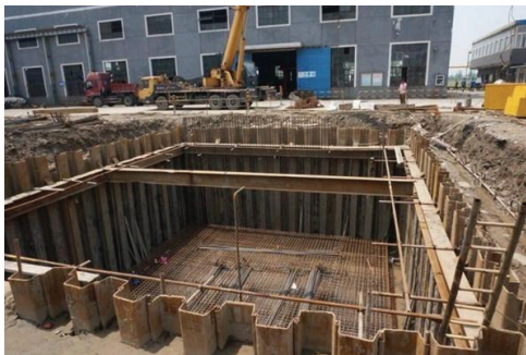
图2 地基加固现场
