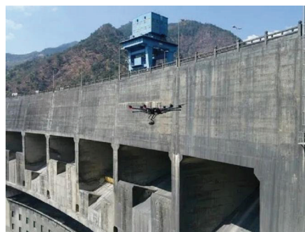
图二 无人机巡检水电站
