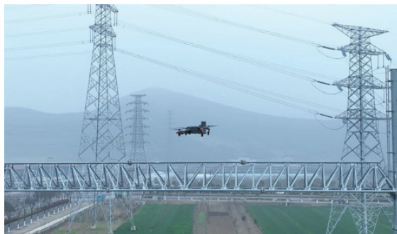
图一 无人机巡检
