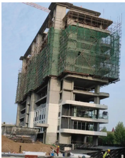
图1 住宅建筑施工现场
