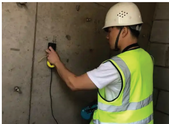
图1 混凝土超声波检测
