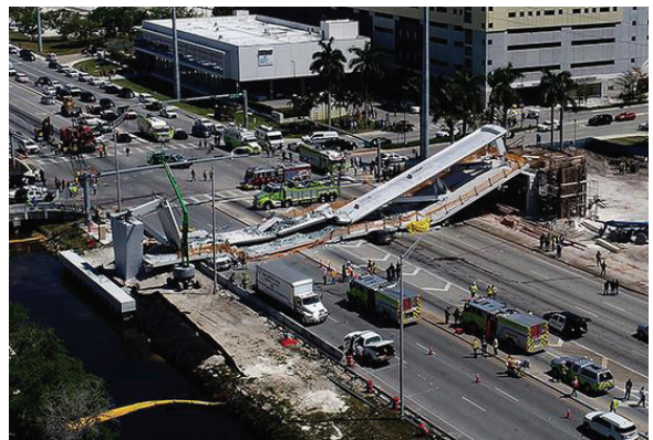
图1 美国迈阿密人行天桥坍塌现场
