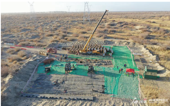
图1 沙戈荒地区风沙天气下的风电工程施工现场
