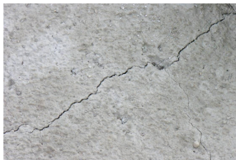
图1 温度裂缝
