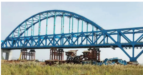
图1 银西高铁跨黄河特大桥
