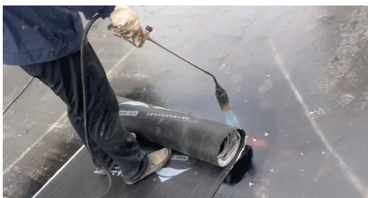
图1 卷材防水施工现场
