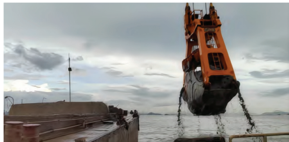
图2 挖槽施工技术
