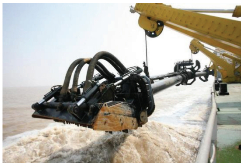
图1 港口航道疏浚施工作业
