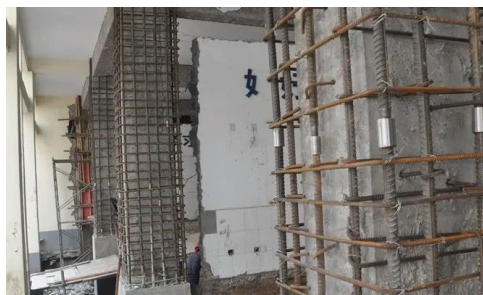
图2 钢筋外包柱加固
