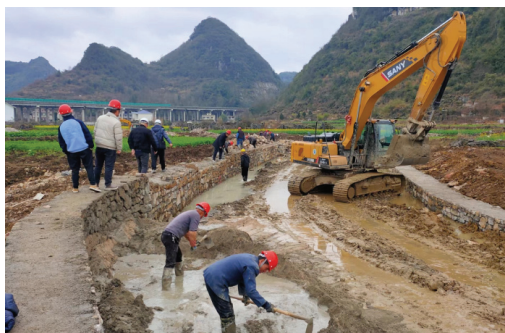
图1 水利工程施工现场
