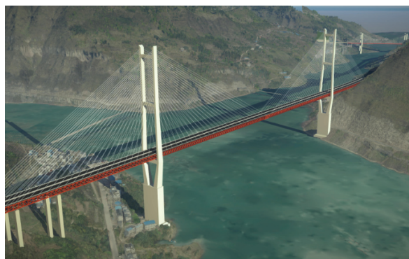
图1 公路桥梁BIM模型
