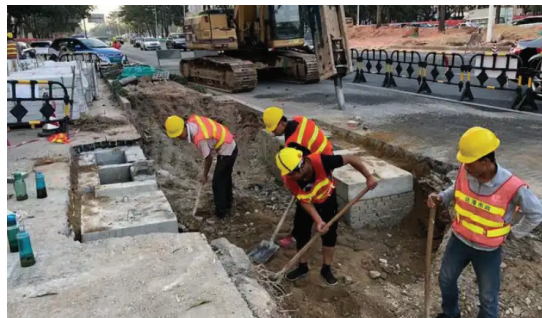
图1 市政工程施工现场
