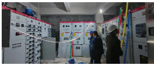
图1 配电室设备安装现场
