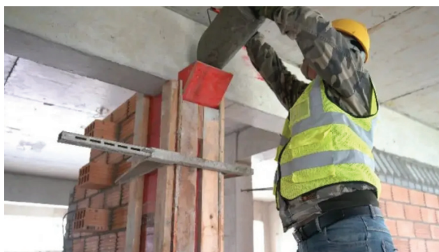
图1 填充墙砌体工程施工现场
