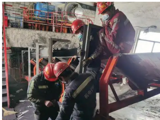
图1 机电安装现场
