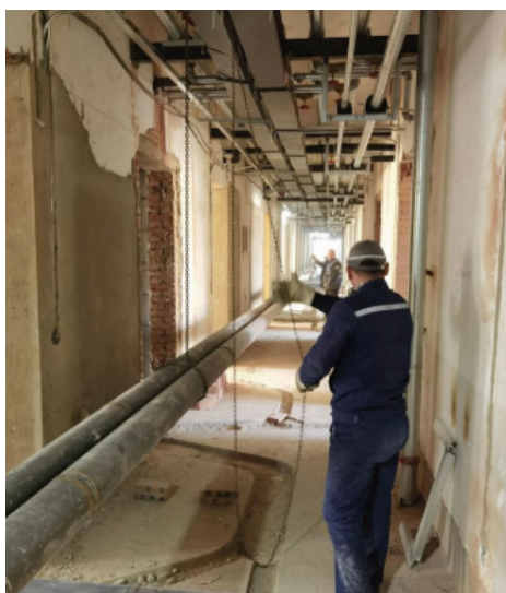
图1 暖通施工现场
