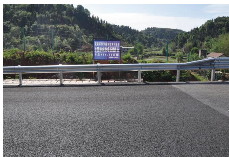
图1 排水降噪混凝土路面
