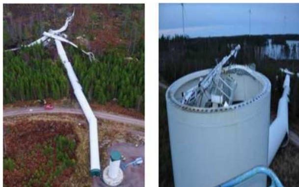
图 1 螺栓失效导致的风电事故
