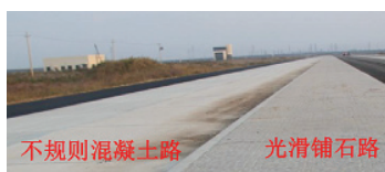
图3 不规则混凝土路
