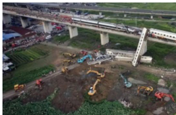
图1 甬温动车追尾特大事故现场图
