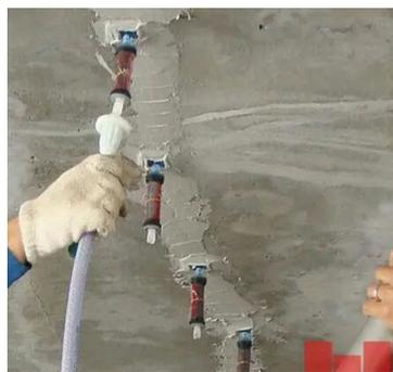
图1 混凝土裂缝灌浆修补施工图
