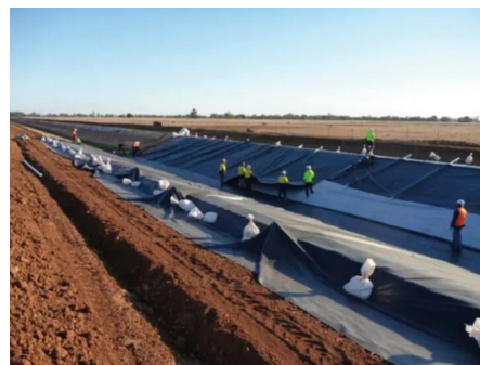
图2 渠道防渗施工
