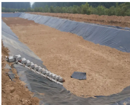
图3 水库防渗施工
