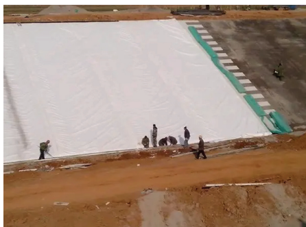
图1 大坝防渗施工
